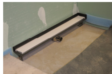
Nachdem die Aussparungsschalung entfernt ist, kann mit dem Einbau begonnen werden. Dazu wird die Duschrinne sorgfältig ausgerichtet.
